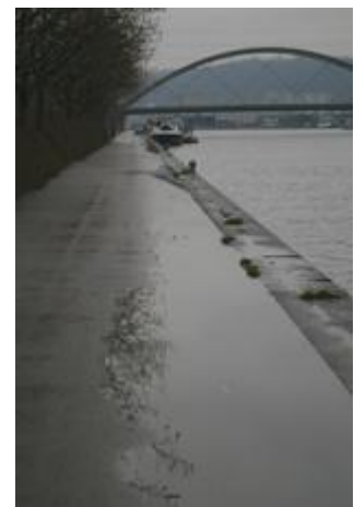
Fig. 43 : Amont du pont Marexhe.
