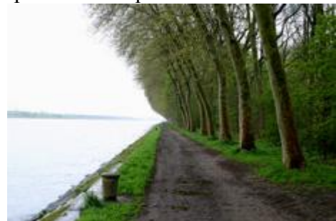
Fig. 62 : Berge en amont du pont.
