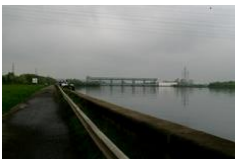
Fig. 25 : Aval du pont rail de Visé.
