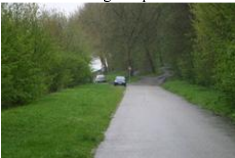
Fig. 61 : Rampe amont du pont de Lanaye.
