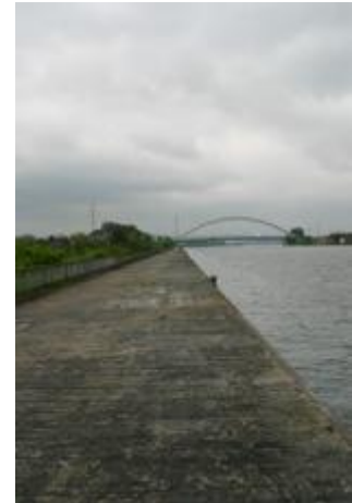
Fig. 36 : Berge à Haccourt.
