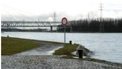
Fig. 56 : Port communal de Haccourt.
