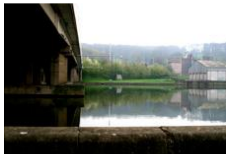
Fig. 71 : Pont de Hermalle.
