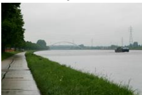
Fig. 54 : Aval du pont de Haccourt.
