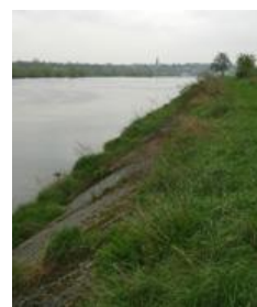
Fig. 78 : Berge bétonnée à hauteur de Lanaye.
