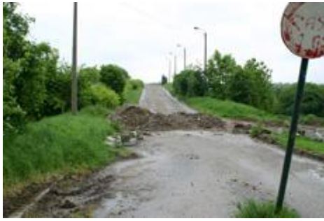
Fig. 81 : Rampe de l'ancien pont de Vivegnis.
