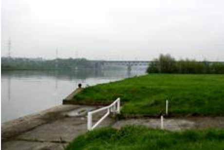
Fig. 75 : Rampe de mise à l'eau.
