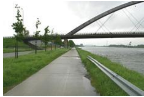
Fig. 82 : Pont de Hermalle.
