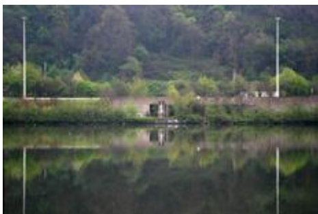
Fig. 7 : Passage piétonnier sous la E25.
