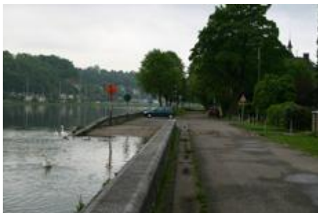
Fig. 23 : Rampe de mise à l'eau.
