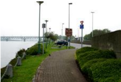
Fig. 11 : Aval du pont de Visé.
