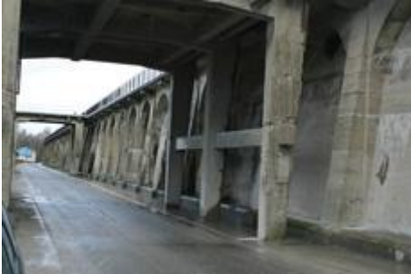
Fig. 57 : Mur de la cimenterie.
