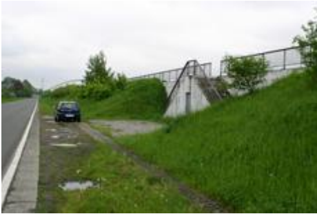
Fig. 35 : Parking en contrebas du canal.
