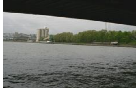
Fig. 58 : Cimenterie de Haccourt.
