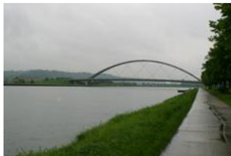
Fig. 52 : Pont de Hermalle.
