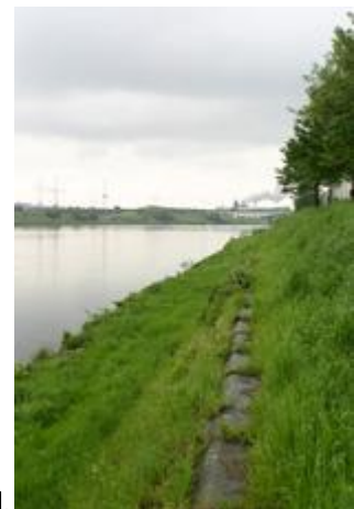
Fig. 3 : Plancher à Chertal.
