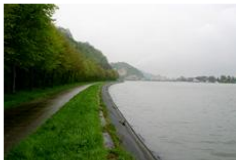
Fig. 64 : Berge en aval du pont.
