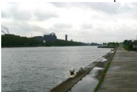
Fig. 49 : Aval du pont de Vivegnis.
