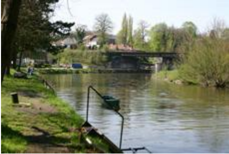
Fig. 52 : Landelies, écluse et pont rails n°13.
