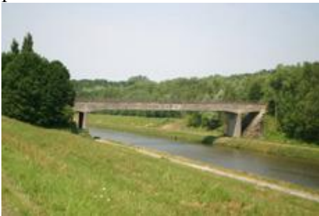
Fig. 67 : Pont route des communes à Godarville.
