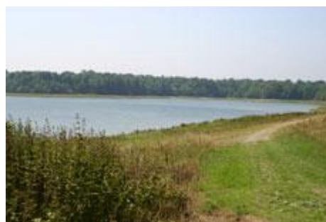
Fig. 142 : Extrémité de l'accès et berge.
