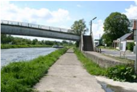
Fig. 78 : Passerelle piétonne de Luttre.
