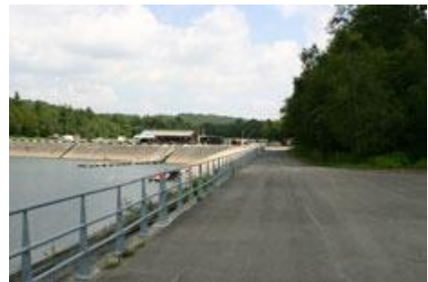
Fig. 89 : Port et zone de stationnement.
