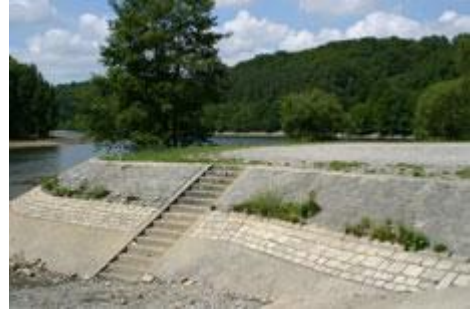
Fig. 153 : Berge au niveau de l'accès.
