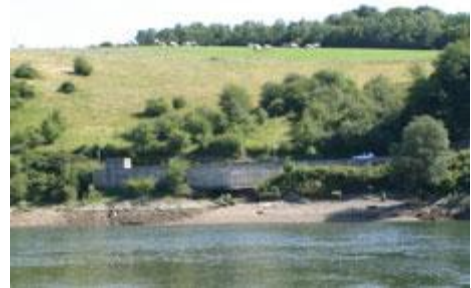
Fig. 91 : Etat de la berge à ce niveau.
