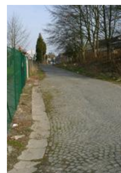
Fig. 21 : Rampe du pont.
