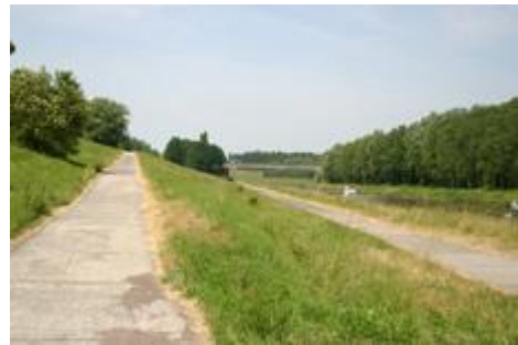
Fig. 68 : Rampe d'accès aval du pont.
