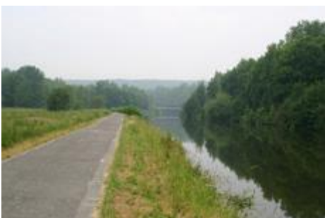
Fig. 44 : Amont du pont rails n°11.
