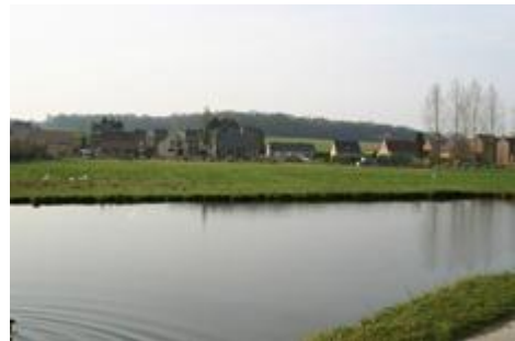
Fig. 2 : Amont du pont de Solre.
