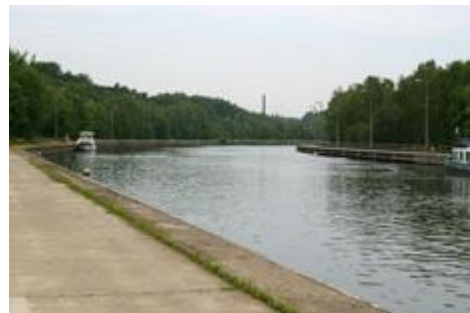
Fig. 63 : Amont de l'écluse de Viesville.
