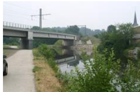
Fig. 31 : Fontaine-Valmont, Pont rails n°4.
