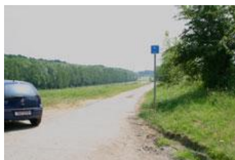
Fig. 174 : Rampe du pont.
