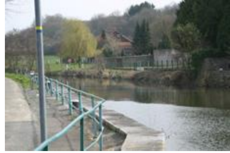
Fig. 6 : Aval de l'écluse de La Buisnière.
