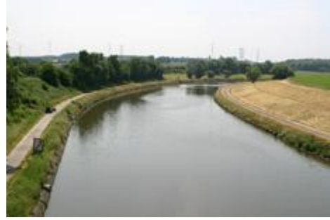
Fig. 66 : Amont du pont de Gouy.
