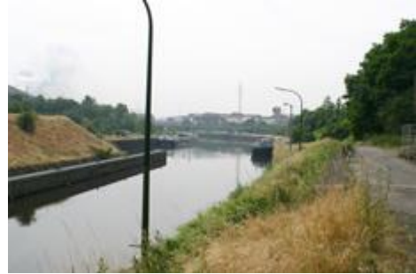
Fig. 57 : Aval de l'écluse de Marchienne.
