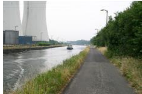
Fig. 59 : Centrale électrique de Monceau.
