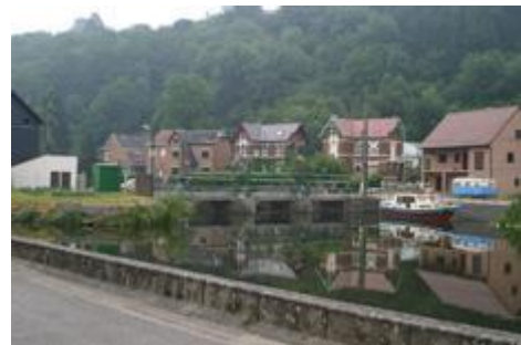
Fig. 10 : Barrage de l'écluse de Thuin.
