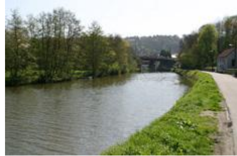
Fig. 53 : Aval du pont rails n°13.
