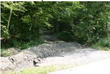
Fig. 154 : Tranchée coupant le 3 ème accès.
