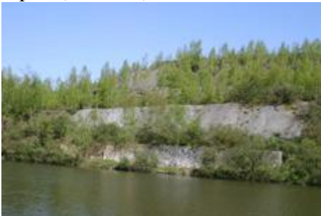
Fig.15 : Amont du pont rail n°15.
