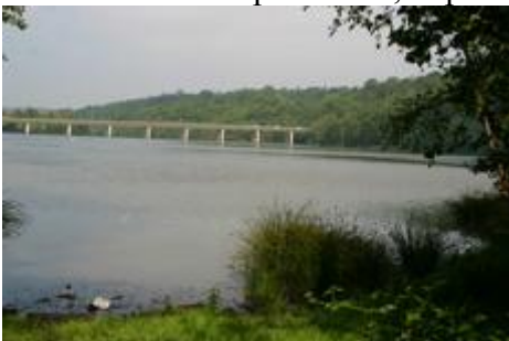
Fig. 156 : Pré barrage du Ry-Jaune.
