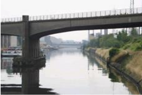
Fig. 56 : Pont route de Bayemont.
