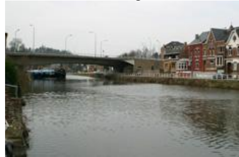
Fig. 41 : Viaduc de Thuin.
