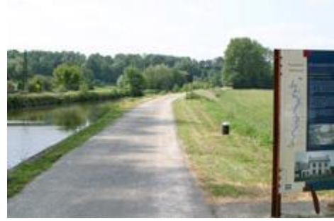
Fig. 171 : Ecluse de Fontaine-Valmont.
