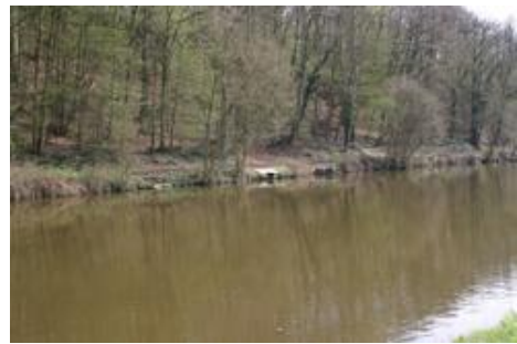
Fig. 12 : Plancher en aval de l'écluse.
