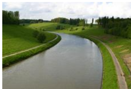
Fig. 84 : Vue du pont des communes.
