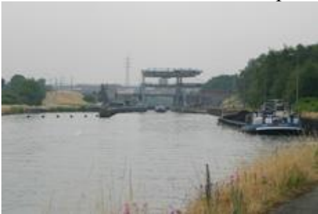
Fig. 58 : Amont de l'écluse de Marchienne.
