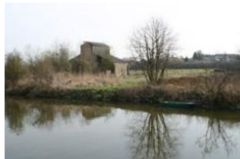
Fig. 4 : Aval du pont rails n°1.
