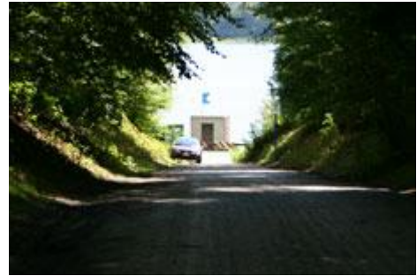
Fig. 147 : Accès à la cabine.
