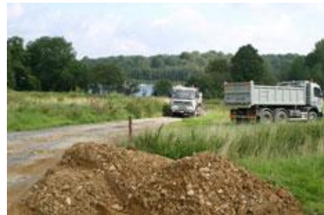
Fig. 131 : Travaux au niveau de l'accès.
