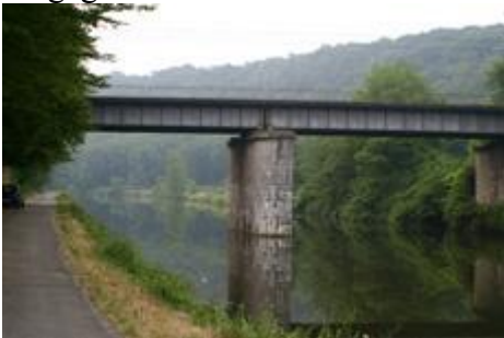
Fig. 42 : Pont rails n°10.
