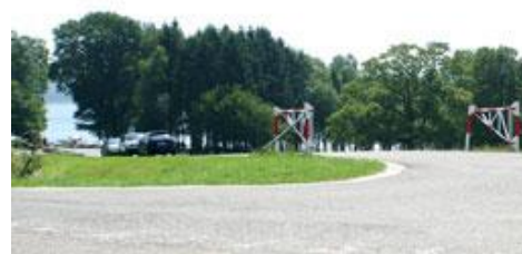
Fig. 145 : Accès à la rampe de mise à l'eau.
