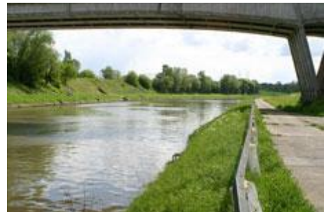
Fig. 179 : Berge au niveau de l'accès.
