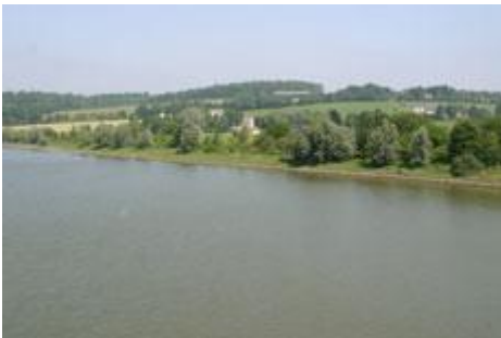
Fig. 92 : Rive orientale vue du pré barrage.
