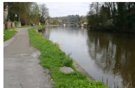
Fig. 173 : Amont du pont de Lobbes.
