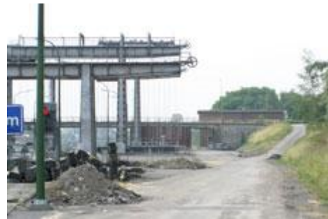
Fig. 182 : Accès rue de la Jonction.
