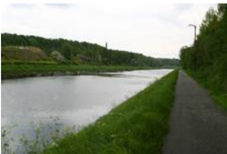
Fig. 71 : RAVeL au pont rails de Jumet à Roux.
