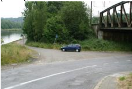
Fig. 62 : Aval de l'écluse de Viesville.
