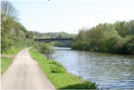
Fig. 54 : Aval du viaduc de Landelies.
