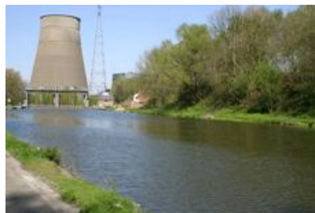
Fig. 163 : Ecluse de Monceau.
