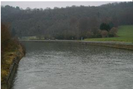
Figure 24 : Aval du barrage de Houx.
