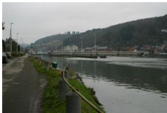
Figure 61 : Amont de l'écluse de Dinant.
