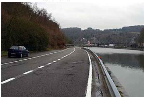
Figure 56 : Amont du pont-rails d'Anseremme.
