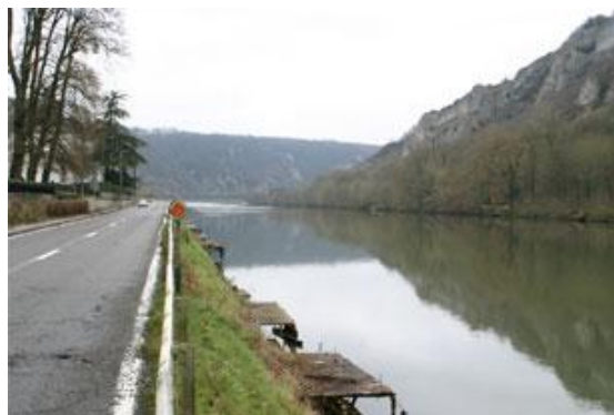
Figure 51 : Sortie de l'agglomération.
