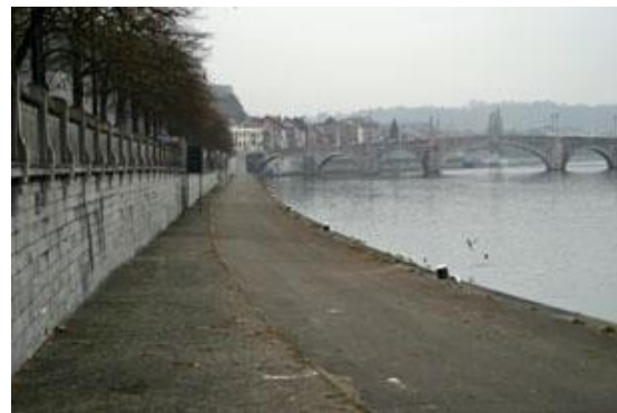
Figure 98 : Amont du pont de Jambes.
