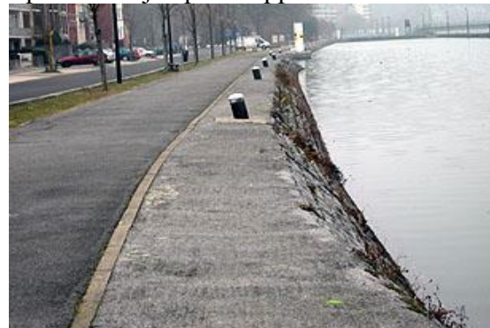
Figure 96 : Av. F. Rops en amont de l'écluse.
