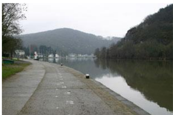
Figure 79 : Zone de captage à l'entrée de Rivière.
