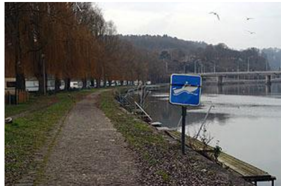
Figure 69 : Amont du pont d'Yvoir.
