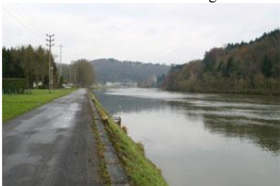
Figure 46 : Aval de l'écluse d'Hastière.
