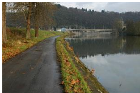
Figure 47 : Amont du pont d'Hastière.
