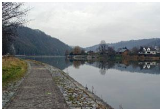
Figure 71 : Amont des Carrières Michaux.
