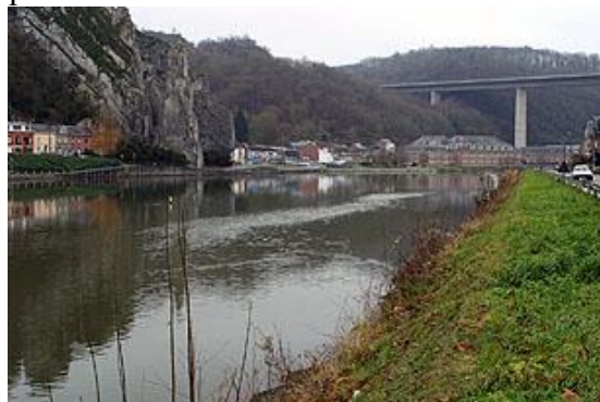
Figure 59 : Berge en aval du viaduc.
