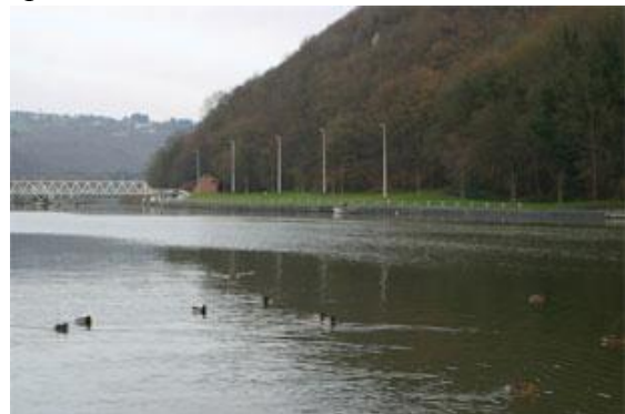
Figure 5 : Rive droite en amont du barrage.
