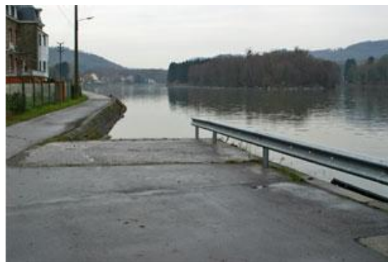
Figure 43 : Mise à l'eau de la rue Bac du Prince.
