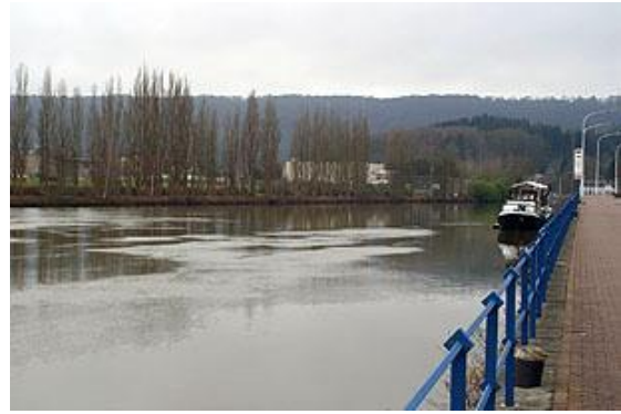
Figure 87 : Berge à hauteur de l'usine de Tailfer.
