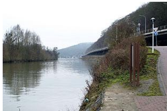
Figure 83 : Jonction avec la N96 en aval du pont.
