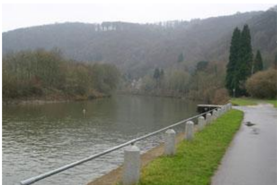
Figure 10 : Aval du barrage de Waulsort.
