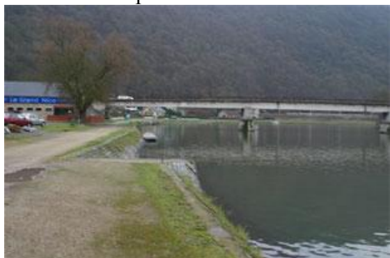
Figure 75 : Amont du pont de Rouillon.
