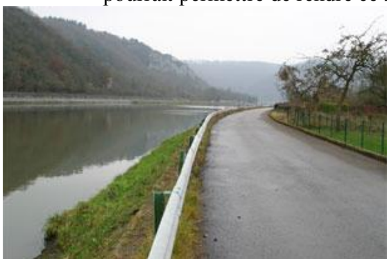
Figure 8 : RAVeL à l'amont du barrage de Waulsort.
