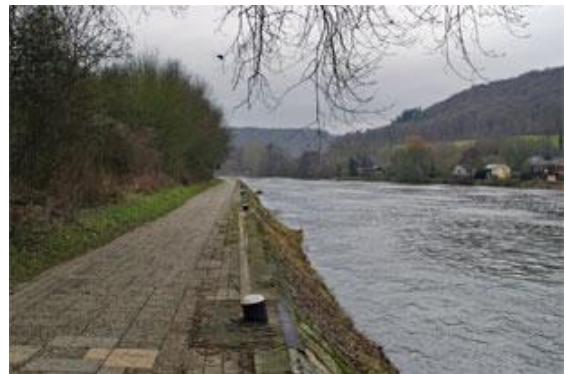
Figure 90 : Aval de l'écluse de Tailfer.
