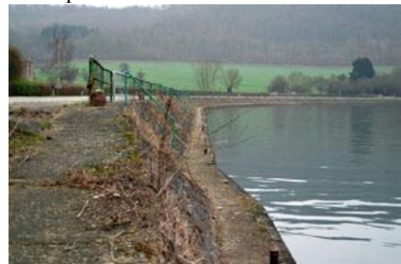
Figure 25 : Banquette en aval du barrage.
