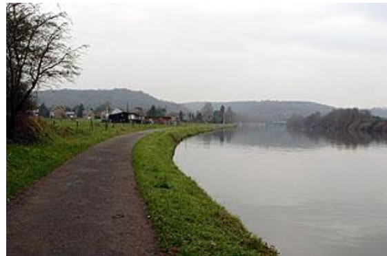
Figure 67 : Aval du pont-rails de Houx.
