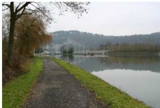
Figure 65 : Amont de l'écluse de Houx.
