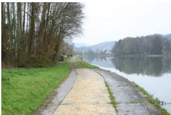
Figure 70 : Aval du pont d'Yvoir.
