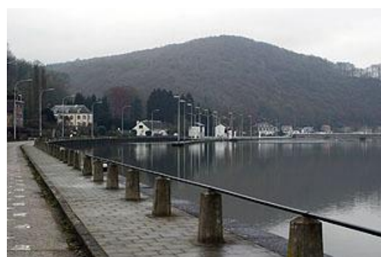
Figure 80 : Amont de l'écluse de Rivière.
