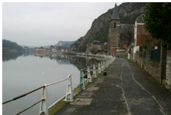
Figure 17 : Aval du viaduc Charlemagne.
