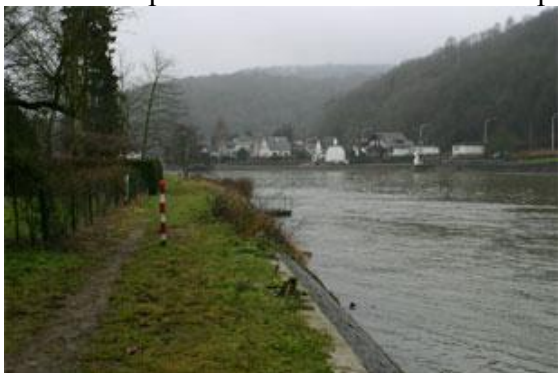
Figure 34 : Amont du pont de Lustin.
