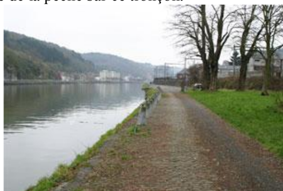
Figure 63 : Berge en aval de l'ancienne gare.
