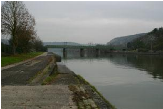
Figure 66 : Amont du pont-rails de Houx.
