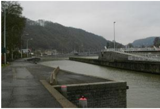
Figure 81 : Aval de l'écluse.
