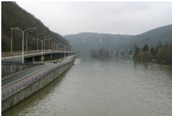
Figure 82 : Aval du pont de Lustin.
