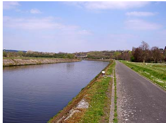
Figure 26 : Aval du pont de Tamines
