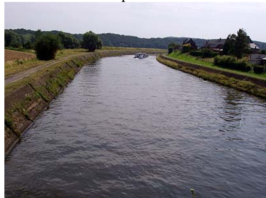
Figure 46 : Vue aval du pont de Soye
