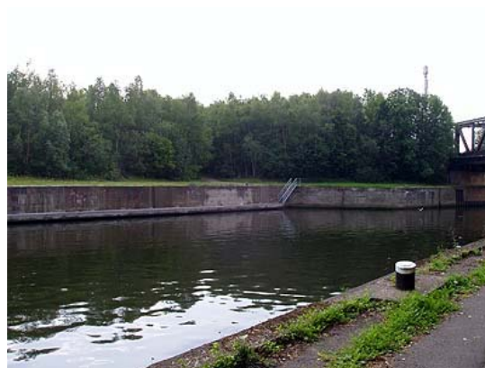
Figure 32 : Aménagement en amont du pont-rails
