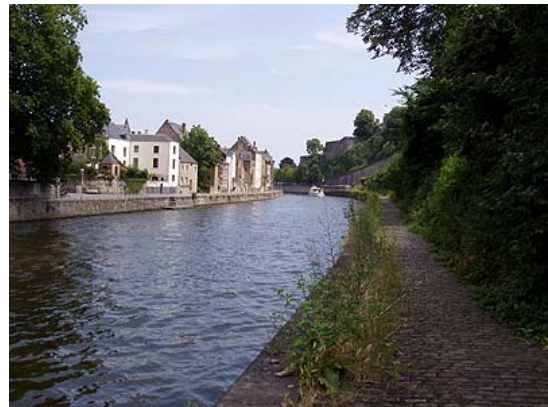
Figure 70 : Aval du pont de l'Evêché
