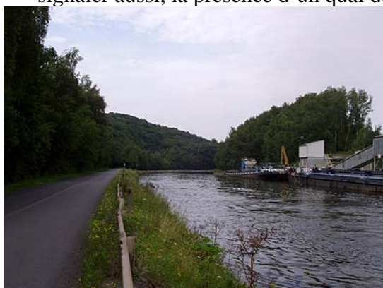
Figure 41 : Quai de chargement Glaverbel
