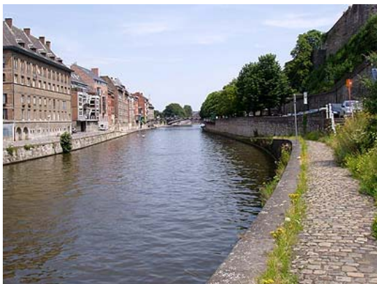
Figure 71 : Pont du Musée et pont de France
