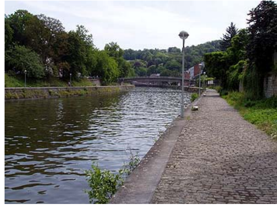
Figure 68 : Passerelle de Salzennes
