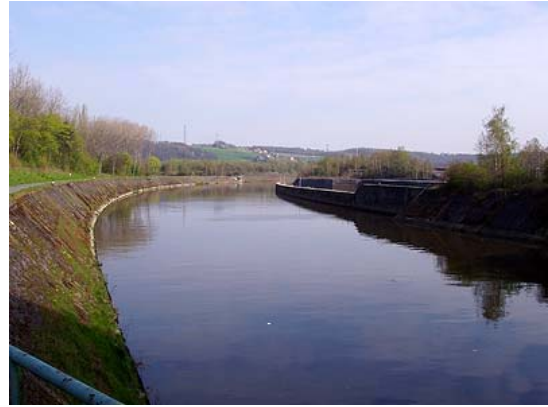
Figure 18 : Aval pont-rails Saint-Jacques
