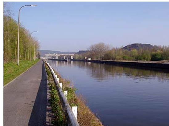
Figure 16 : Amont de l'écluse de Roselies
