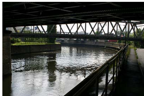
Figure 4 : 2 ème pont du R9
