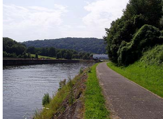
Figure 48 : Amont du pont-rails d'Amptia
