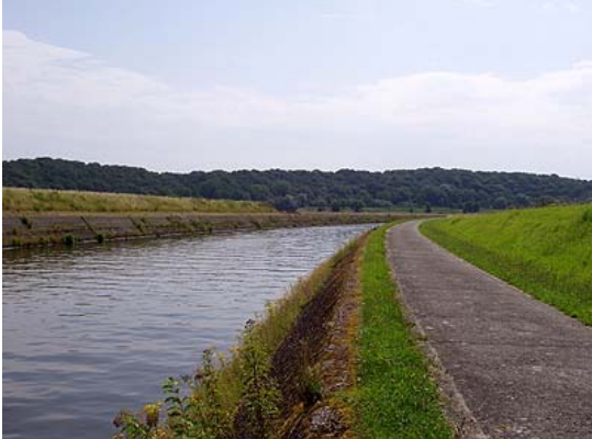
Figure 47 : Aval du pont de Soye
