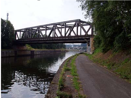
Figure 33 : Pont rails d'Auvelais
