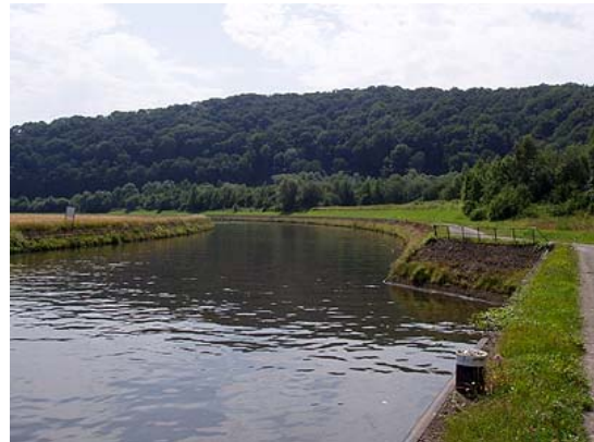
Figure 50 : Aval du pont-rails d'Amptia
