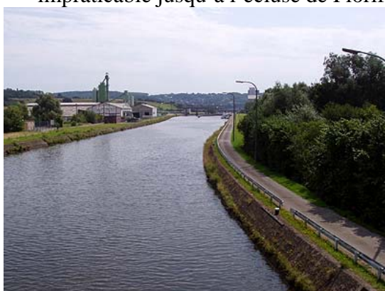
Figure 55 : Vue aval du pont de Floreffe-écluse
