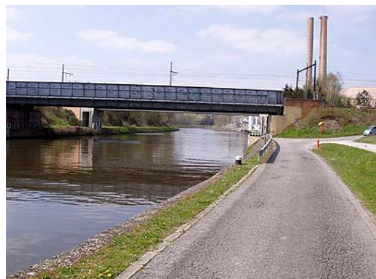
Figure 28 : Pont-rails « Saint Roch »
