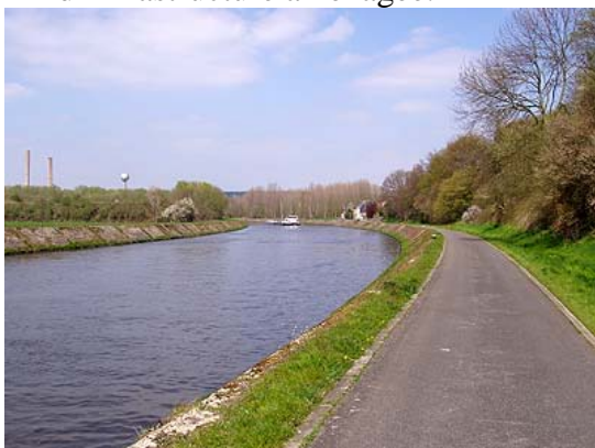
Figure 27 : Aval du pont-rails Tamines/Dinant
