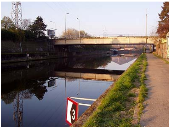
Figure 7 : Pont de Châtelet
