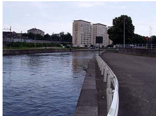
Figure 66 : Aval de l'écluse de Salzinnes
