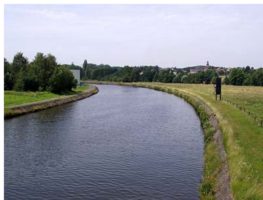
Figure 54 : Vue amont du pont de Floreffe-écluse
