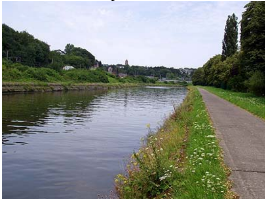
Figure 63 : Aval du pont-rails de Ronet
