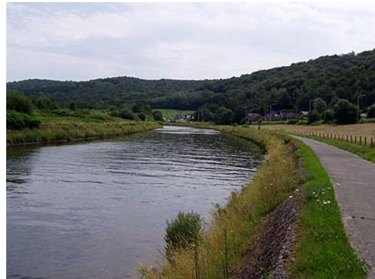
Figure 60 : Rive droite à hauteur de la gare
