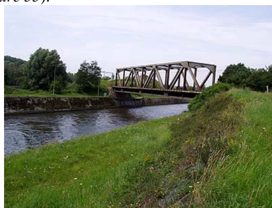
Figure 56 : Pont-rails de Floriffoux
