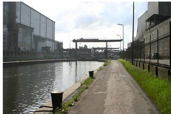
Figure 2 : Ecluse de Marcinelle
