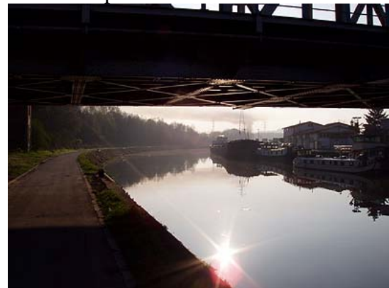
Figure 12 : Pont de Pont-de-Loup
