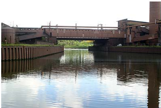
Figure 1 : Confluence entre la Sambre et le Canal
