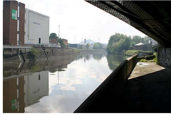
Figure 6 : Pont-rails du Poirier
