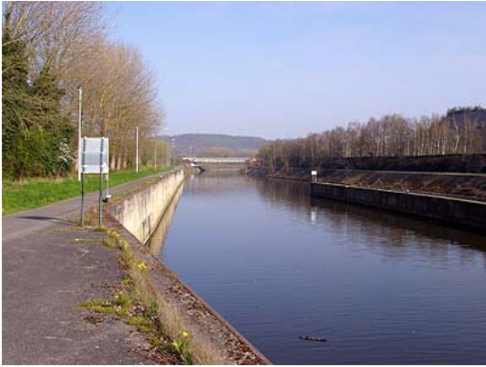
Figure 17 : Aval de l'écluse de Roselies
