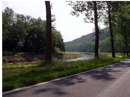
Figure 44 : Aval de l'écluse de Mornimont
