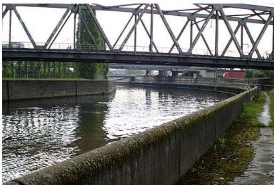
Figure 3 : Aval de l'écluse de Marcinelle
