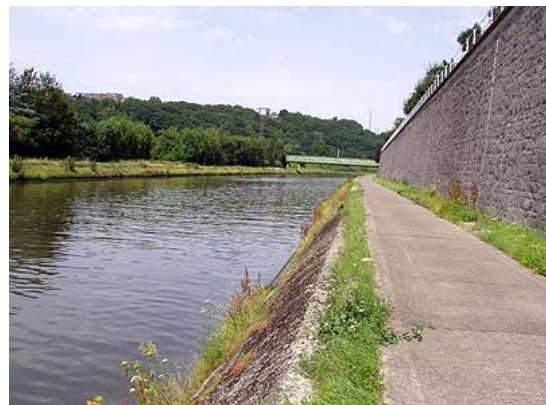
Figure 62 : Pont-rails de Ronet
