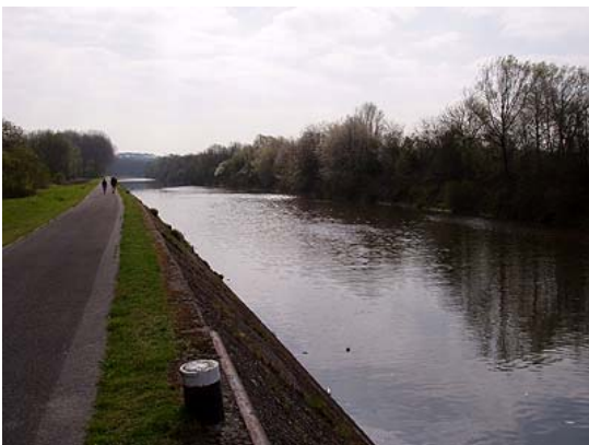
Figure 21 : Aval du pont-rails de Bonne Espérance
