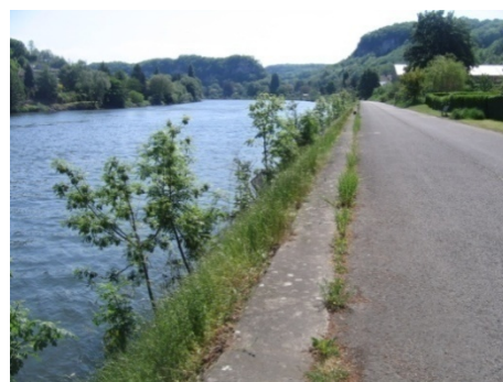
Figure 113 : Végétation rivulaire aval du port de Maizeret
