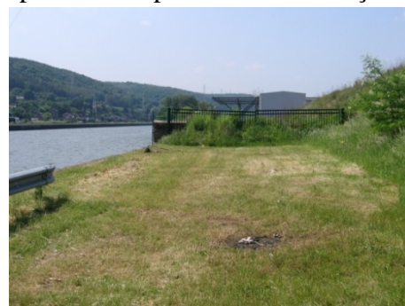
Figure 57 : Accès interdit au niveau du zoning industriel
