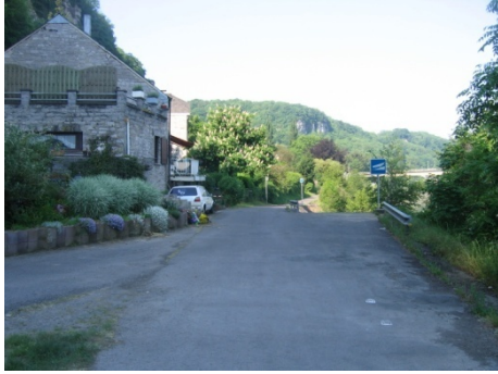
Figure 114 : Rampe de mise à eau en aval du port de Samson
