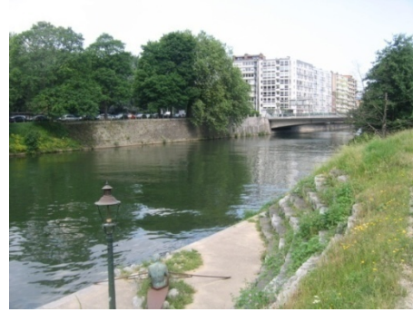
Figure 169 : Dérivation de la Meuse au niveau de la rue des Vennes
