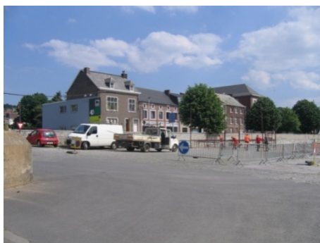
Figure 73 : Zone de stationnement pont d'Engis
