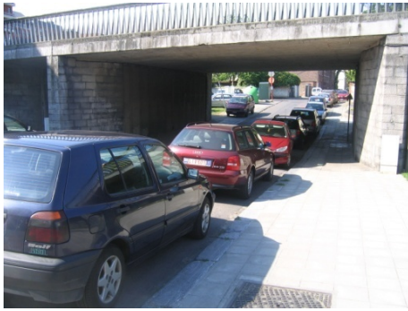
Figure 95 : Parking en amont du pont des Ardennes
