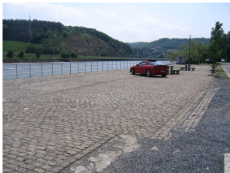
Figure 58 : Rampe de mise à eau à Haute Flône
