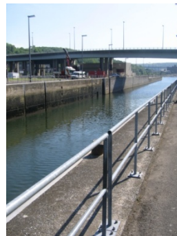
Figure 102 : Amont de l'écluse Grands Malades
