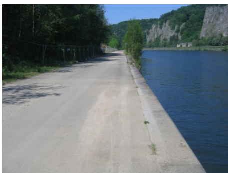
Figure 110 : Chemin de halage en amont de l'ancienne écluse de Maizeret
