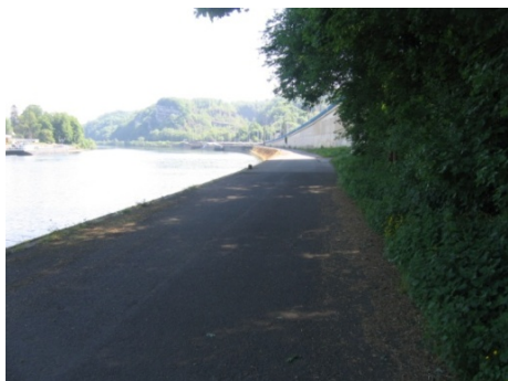
Figure 106 : Chemin de halage en aval du Viaduc de Beez
