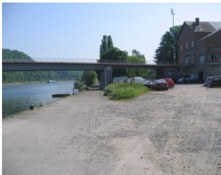
Figure 117 : Pont de Sclayn
