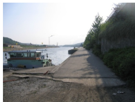
Figure 127 : Chemin de halage en aval du pont d'Andenne
