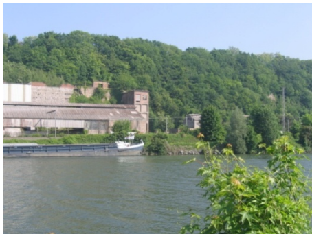
Figure 70 : Aval de la Réserve Dumont - Wauthier
