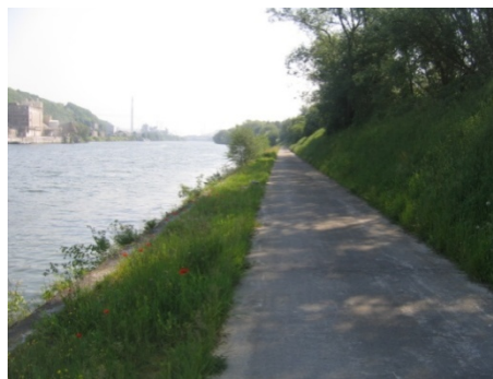
Figure 145 : Chemin de halage en aval de la zone portuaire d'Hermalle-sous-Huy
