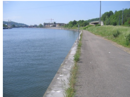
Figure 8 : Amont de l'écluse de Grands-Malades
