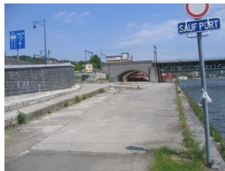
Figure 4 : Amont du pont rail
