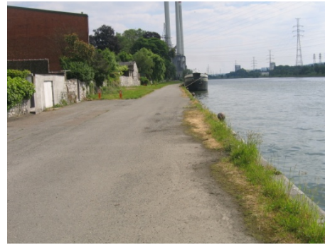
Figure 77 : Chemin de halage au niveau de la rue Vinâve
