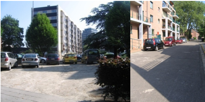
Figure 42 : zone de stationnement en aval du pont de Rails Hesbaye-Condroz
