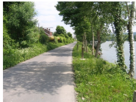
Figure 67 : Chemin de halage en direction de Flemalle (aval du pont d'Hermalle-sous-Huy)
