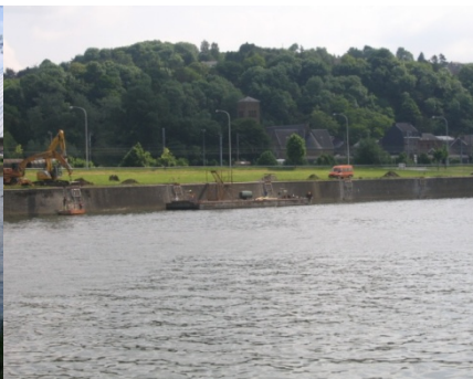
Figure 38 : Chemin de halage en aval du pont Ben-Ahin
