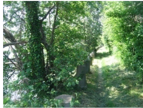
Figure 65 : Zone non accessible et non praticable en amont du pont d'Hermalle-sous-Huy
