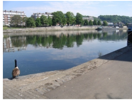
Figure 96 : Aval du pont des Ardennes
