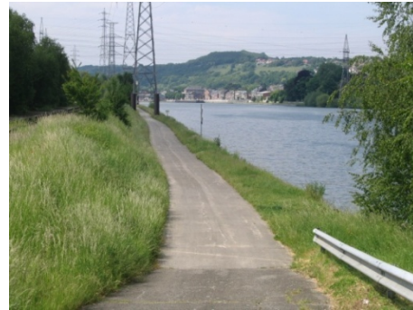
Figure 151 : Chemin de halage au niveau du passage à niveau de Ramet
