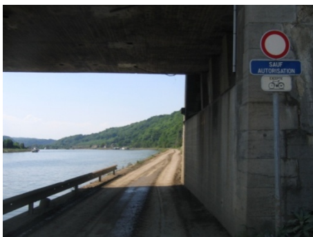
Figure 19: Pont de Sclayn
