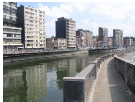
Figure 172 : Pont de Longdoz
