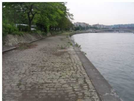
Figure 88 : Chemin de halage au niveau du Boulevard Frère Orban
