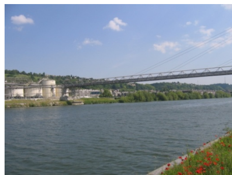
Figure 75 : Quai du halage au niveau d'Engis
