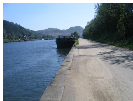
Figure 111 : Chemin de halage en amont de l'ancienne écluse de Maizeret
