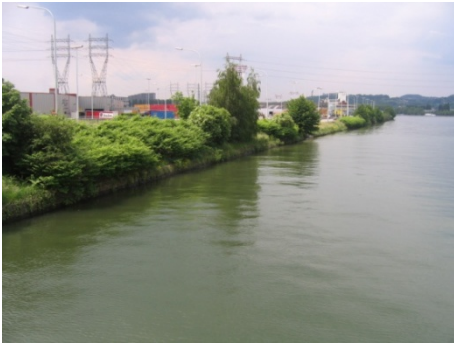
Figure 167 : Barrage de Monsin
