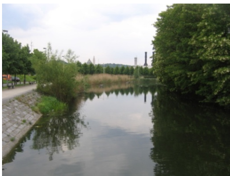
Figure 180 : Amont pont levis Belle-Ile
