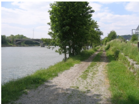
Figure 66 : Chemin de halage en direction de Huy (aval du pont d'Hermalle-sous-Huy)
