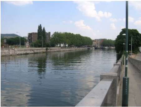
Figure 174 : Pont de Bressoux
