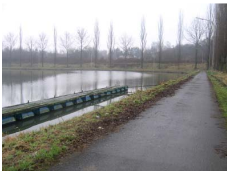
Figure 38 : berge impraticable en amont du pont route de Ronquières
