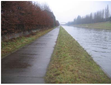
Figure 22 : berge praticable en aval du pont rails SCNB
