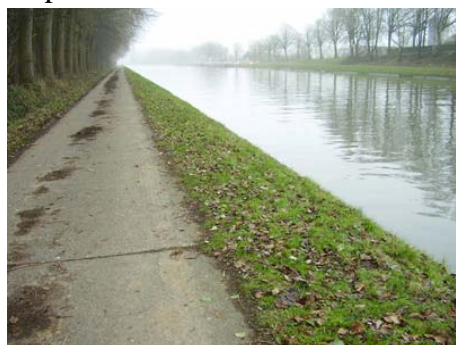
Figure 28 : zone praticable au-delà de la confluence entre la branche de Seneffe et le canal Charleroi-Bruxelles
