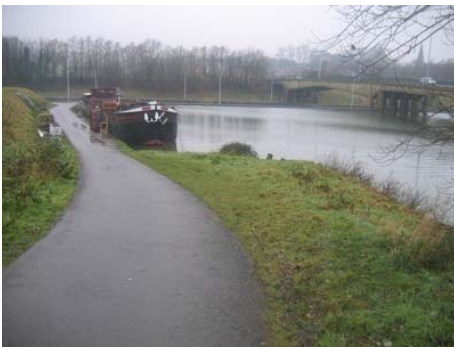
Figure 56 : berge impraticable, à partir de l'écluse n° 28, en raison de la hauteur du surplomb
