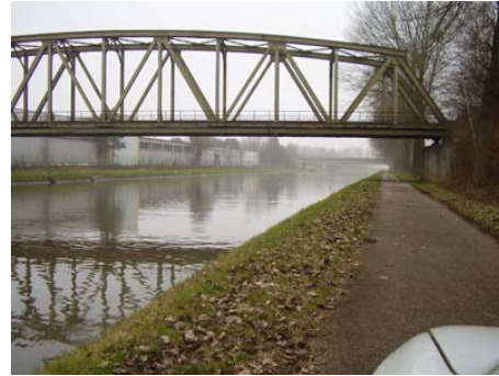
Figure 31 : berge praticable en amont du pont rails de Soudromont
