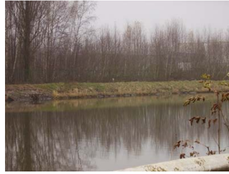
Figure 8 : berge praticable en aval de la glissière de sécurité au niveau du pont autoroute E19
