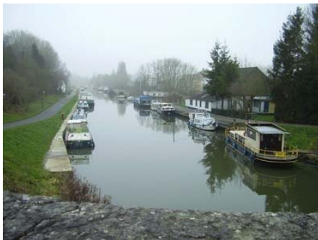
Figure 49 : zone inaccessible et berge impraticable en aval du pont du Blocus
