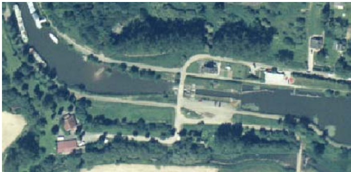
Figure 58 : possibilité de stationner au niveau de l'écluse n° 26
