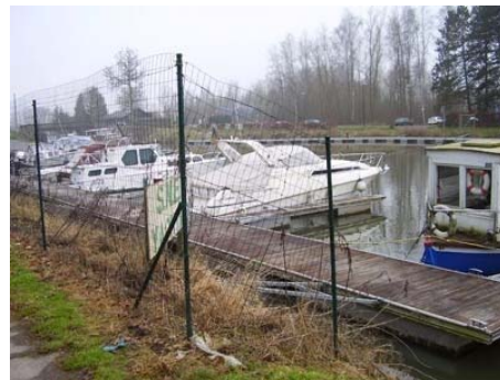
Figure 48 : berge impraticable en raison de la présence d'éléments permanents
