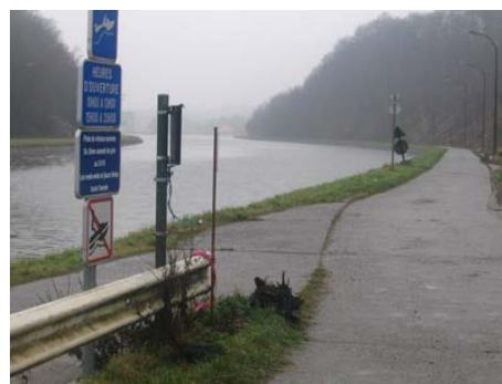
Figure 41 : berge impraticable à cause de la glissière de sécurité et la rampe de mise à eau
