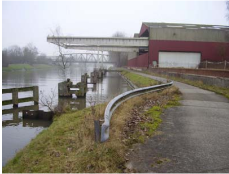
Figure 30 : berge impraticable sur plus de 150 m en amont du pont rail de Soudromont
