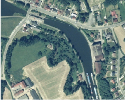
Figure 55 : éléments permanents en aval de l'écluse n° 27
