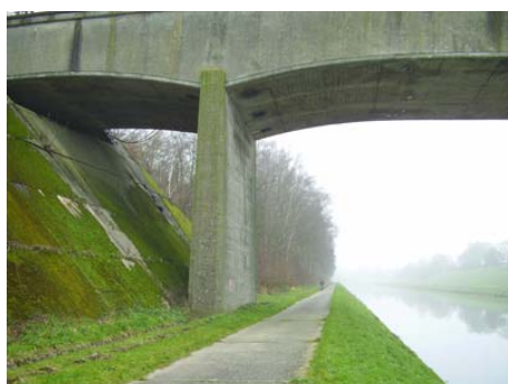
Figure 26 : chemin de halage difficilement accessible au niveau du pont route des communes
