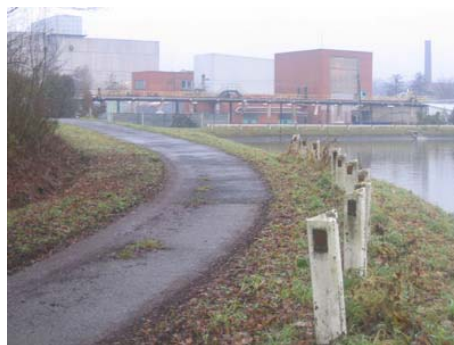
Figure 15 : berge impraticable en raison de potelets
