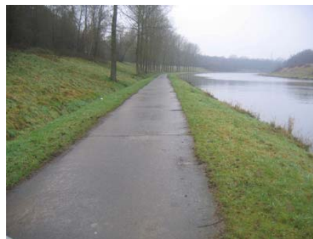
Figure 19 : berge praticable au delà de la zone d'amarrage de l'écluse d'Ittre
