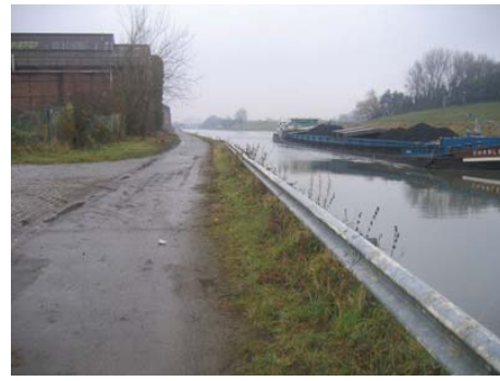
Figure 23 : berge impraticable au niveau du pont route de Clabecq en raison de la présence d'une glissière de sécurité
