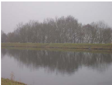
Figure 13 : zone praticable de l'aval du pont route Ecaussines-Lalaing jusqu'au plan incliné de Ronquières
