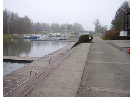
Figure 51 : berge impraticable en amont du pont du Blocus
