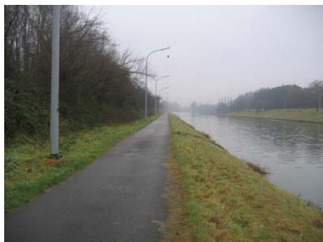
Figure 14 : berge praticable du pont route de Ronquières jusqu'à l'aval du pont route de Fauquez
