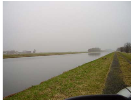
Figure 36 : berge praticable en amont du pont route Ecaussines-Lalaing
