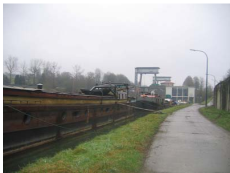
Figure 18 : berge impraticable en raison de la présence d'éléments permanents en aval de l'écluse d'Ittre
