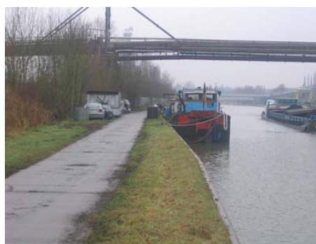
Figure 21 : berge impraticable au niveau de la rue du canal
