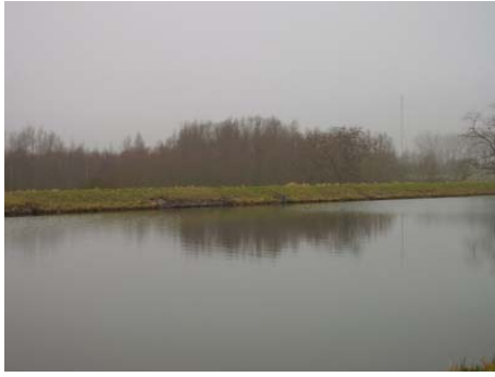
Figure 11 : berge praticable au niveau du pont route Fina Research
