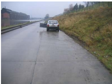
Figure 46 : zone de stationnement le long de la rue Jean Wautrequin
