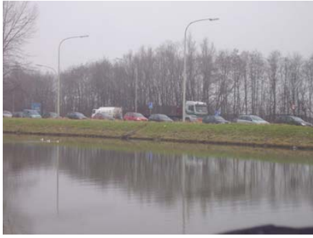
Figure 33 : zone accessible et praticable en aval du pont de l'autoroute E19
