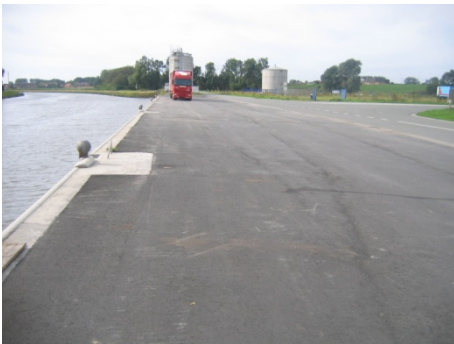
Figure 30 : Quai public de Pecq. Possibilité de stationner
