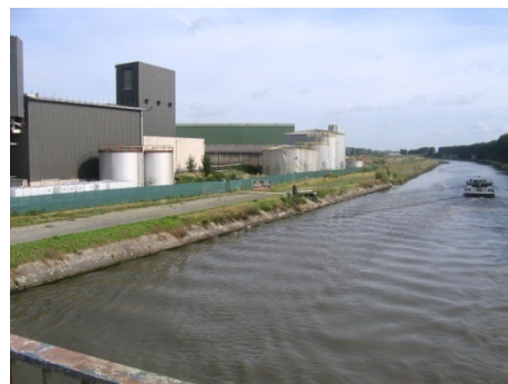
Figure 33 : Chemin de halage en aval du pont de Warcoing
