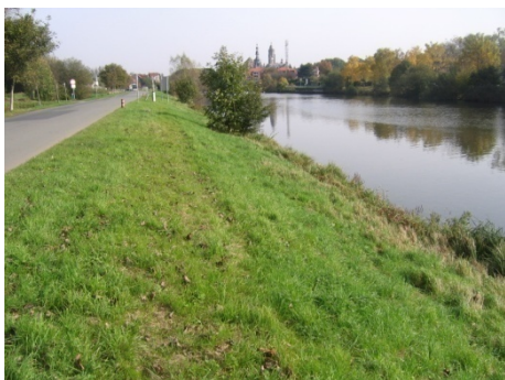
Figure 82 : Berge praticable le long de la route des Ecluses
