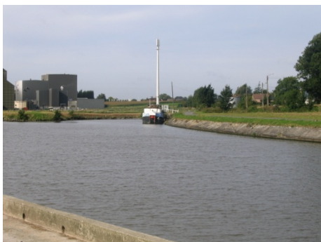
Figure 32 : Rampe de mise à l'eau en aval du pont de Warcoing
