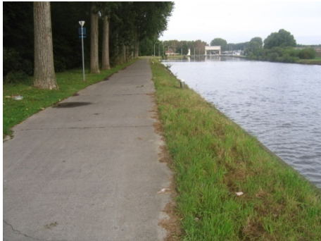
Figure 20 : Chemin de halage au niveau du quai Casterman
