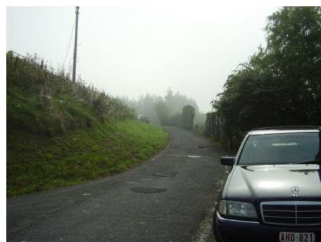
Figure 67 : Zone accessible au niveau du pont Pottes-Helchin
