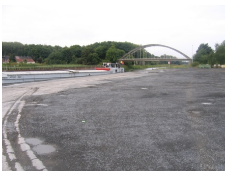
Figure 42 : Zone de stationnement possible en amont du pont de Vaulx-Cherq
