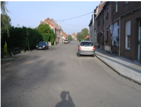
Figure 74 : Chaussée du Pont Rouge
