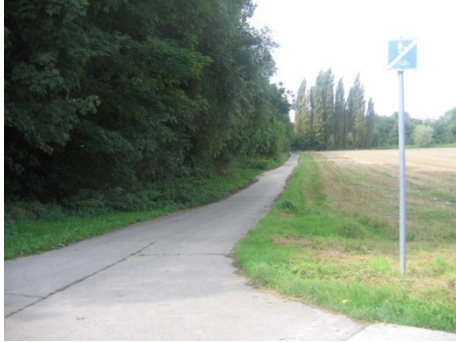
Figure 23 : Chemin d'accès au niveau du pont de Kain Ramegnies-Chin
