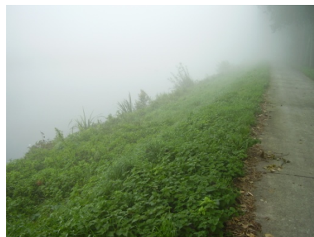
Figure 65 : Terrassement de la berge en aval du pont de Warcoing
