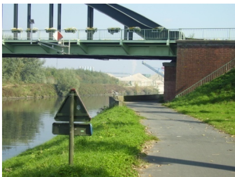
Figure 72 : Berge impraticable au niveau du pont d'Escanaffles
