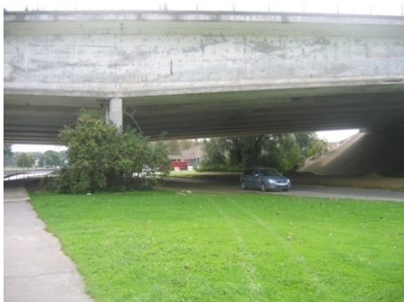
Figure 22 : Pont de l'Autoroute
