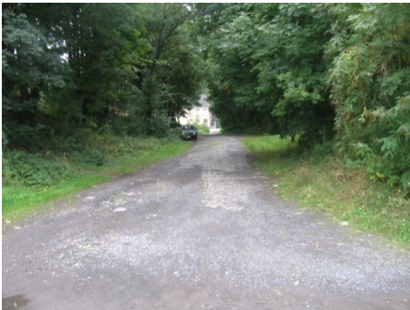
Figure 16 : Accès aval du pont de Vaulx-Cherq
