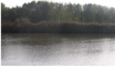
Figure 86 : Berge impraticable en amont du pont Rouge
