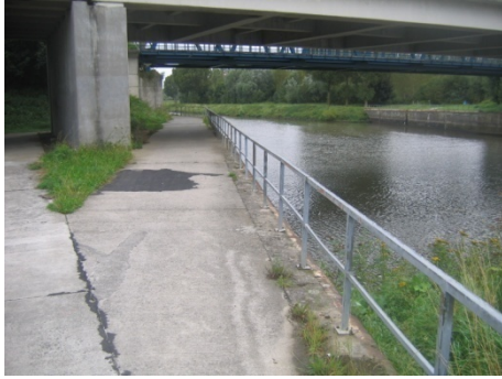
Figure 8 : chemin de halage au niveau du pont route Antoing-Bruyelle
