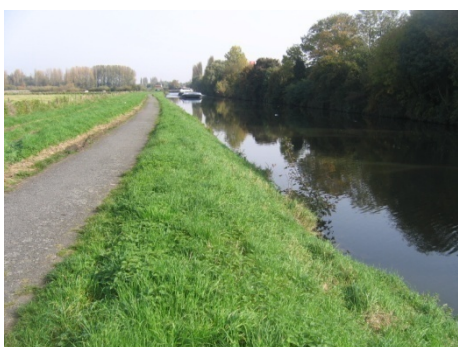
Figure 85 : Berge impraticable en aval du pont de Comines
