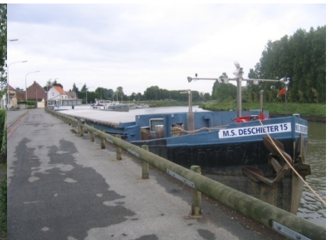
Figure 4 : Eléments permanents le long du chemin de halage
