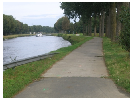
Figure 53 : Chemin de halage au niveau de la rue Edmond Courault
