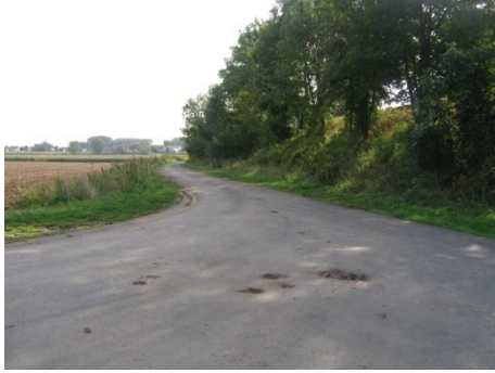
Figure 59 : Zone accessible au niveau de l'accès aval du pont de Pecq-Herrines
