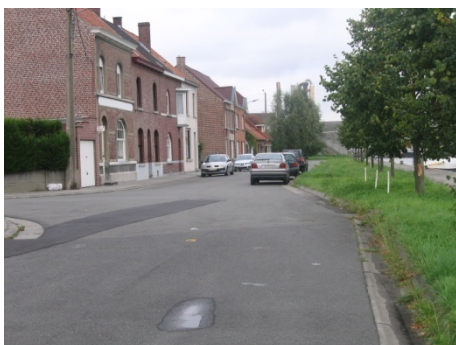
Figure 12 : Chemin de halage au niveau d'Antoing
