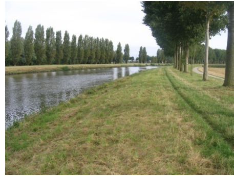
Figure 56 : Berge praticable en aval du pont de Kain Ramegnies-Chin
