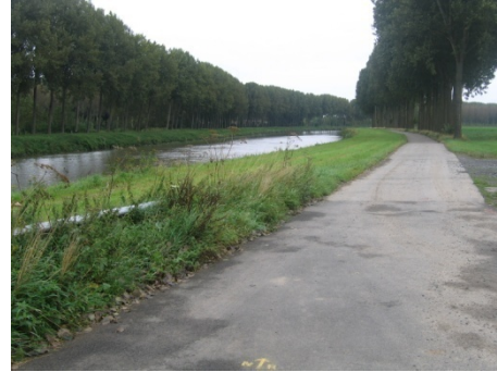
Figure 37 : Zone praticable au niveau du Hangar Couplet
