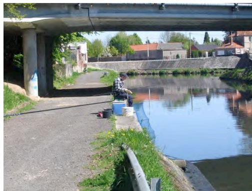
Figure 161 : berge praticable en amont du pont de la passerelle
