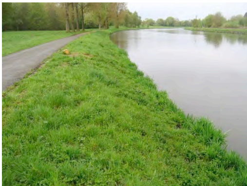
Figure 1 : berge praticable à la confluence entre le Canal Charleroi-Bruxelles et le Canal du Centre
