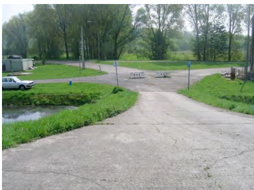
Figure 10 : stationnement le long du chemin des cheminots
