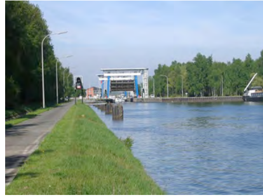
Figure 103 : berge inaccessible et impraticable à l'Ecluse n°1
