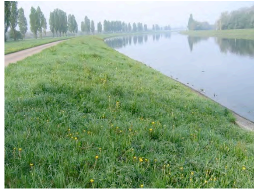
Figure 142 : pratique de la pêche possible en amont du pont route d'Hensies
