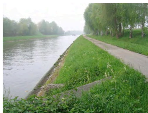
Figure 119 : berge impraticable en aval du pont de l'autoroute de Wallonie
