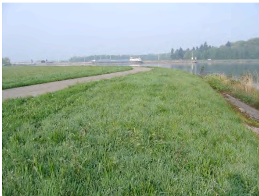
Figure 133 : Chemin de halage inaccessible au niveau du canal Nimy-Blaton-Péronnes
