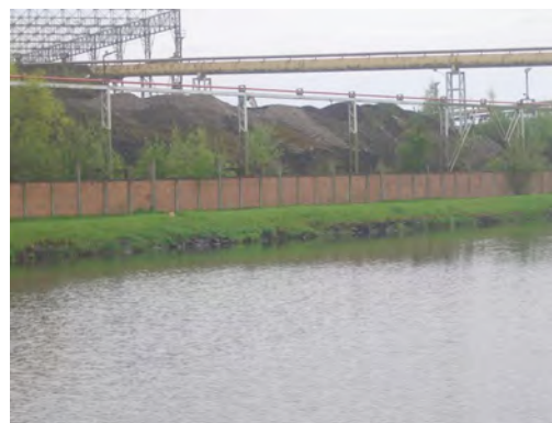
Figure 34 : pratique de la pêche possible au niveau de la passerelle de Boel
