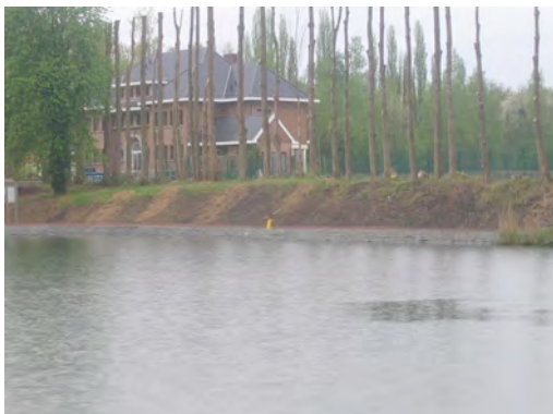
Figure 61 : berge impraticable en aval de l'Ascenseur n°4
