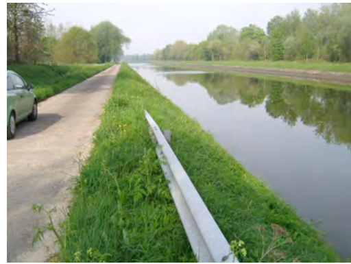
Figure 95 : berge impraticable en aval du pont route Risqu'à Tout
