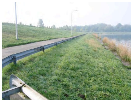
Figure 136 : berge impraticable en aval de l'écluse de Pommeroeul
