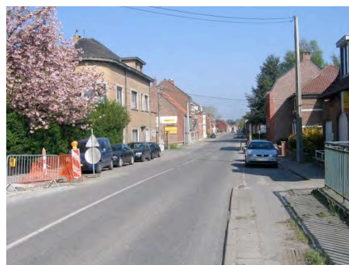
Figure 169 : stationnement des véhicules dans la rue de Mons
