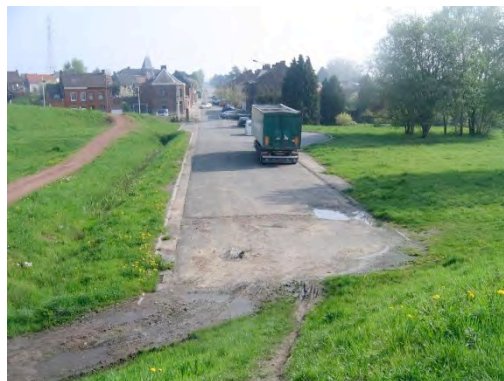
Figure 28 : stationnement possible en fin de la rue de Mons
