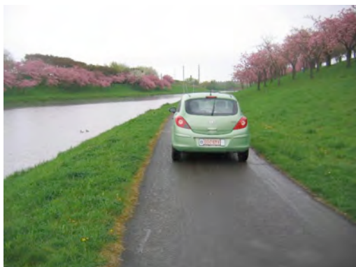
Figure 39 : berge inaccessible à la confluence du Canal du Centre à Grand Gabarit et de la Branche de la Crorière
