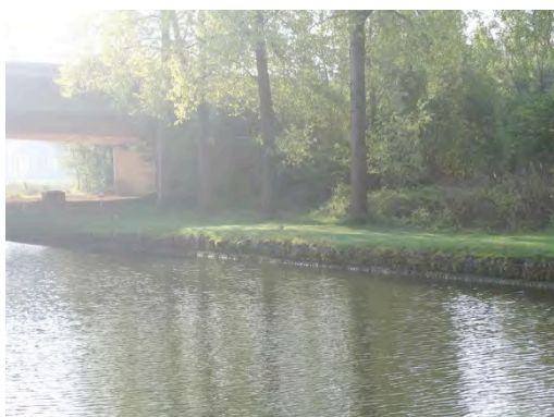
Figure 184 : berge praticable en aval de l'Ecluse n°4
