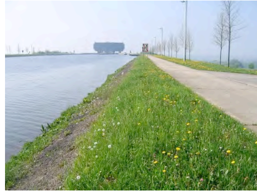
Figure 24 : berge impraticable et inaccessible en amont de l'Ascenseur funiculaire de Strepy
