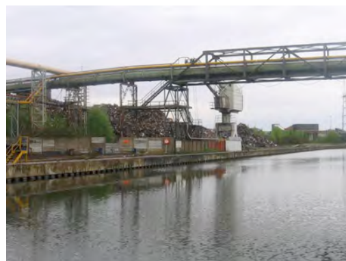
Figure 46 : sécurité des biens et des personnes insuffisante à l'extrémité de la Branche de la Louvière
