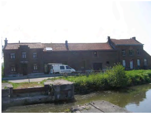
Figure 194 : zone accessible au niveau de l'ancien pont levis Ladrie
