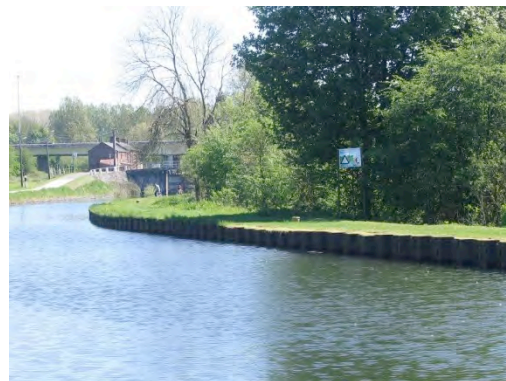
Figure 183 : berge praticable et inaccessible à l'Ecluse n°3
