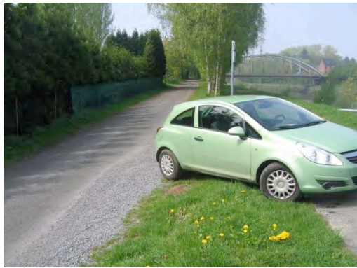
Figure 84 : berge inaccessible rue Pasteur Grégoire
