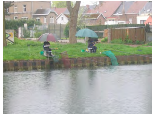
Figure 60 : berge praticable à la passerelle piétonne de Bracquegnies
