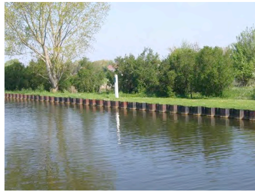
Figure 195 : berge praticable en aval de l'Ecluse n°16
