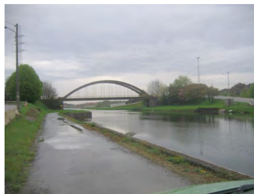
Figure 38 : berge impraticable en aval du pont Tout-Y-Faut
