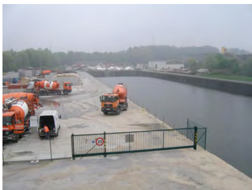
Figure 114 : berge impraticable et inaccessible à la Darse de Baudour
