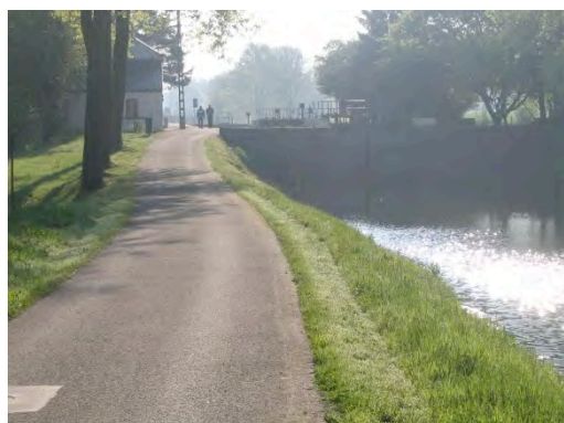
Figure 166 : berge inaccessible à l'Ecluse n°5
