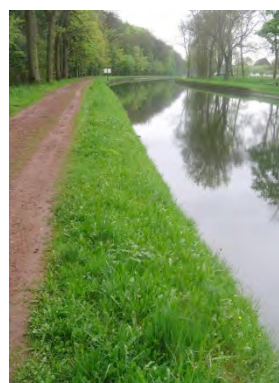
Figure 50 : berge praticable en aval de l'Ascenseur n°1
