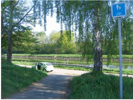
Figure 102 : chemin de halage inaccessible au niveau du pont Charles de Gaulle
