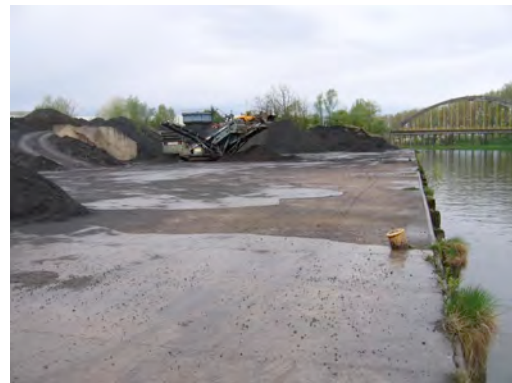
Figure 2 : berge inaccessible et impraticable sur le quai de Manage
