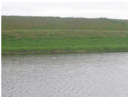
Figure 43 : berge praticable au niveau de la Branche de Croyère
