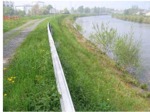
Figure 87 : berge impraticable en aval du pont S.N.C.B.
