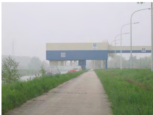
Figure 116 : berge impraticable en aval de la passerelle piétonne
