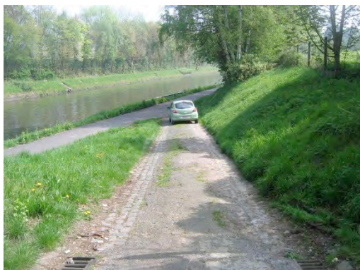
Figure 80 : chemin d'accès interdit aux voitures au niveau de la rue Emile Limaugé
