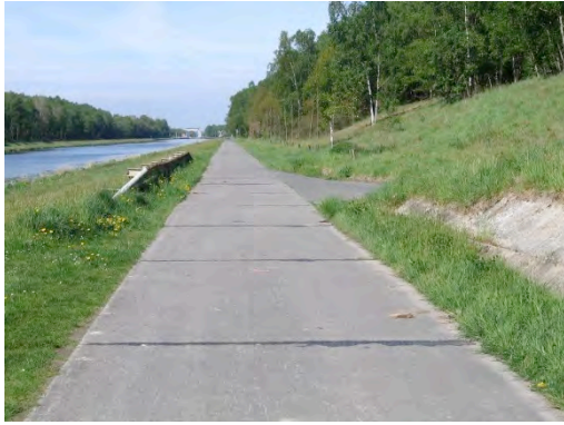
Figure 128 : chemin de halage accessible et berge praticable en amont de l'Ecluse n°1
