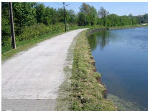
Figure 164 : berge praticable en aval de l'Ecluse n°3
