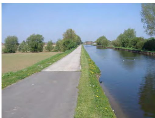
Figure 176 : berge praticable en aval de l'Ecluse n°16
