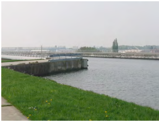
Figure 5 : pont canal du Sart inaccessible aux véhicules
