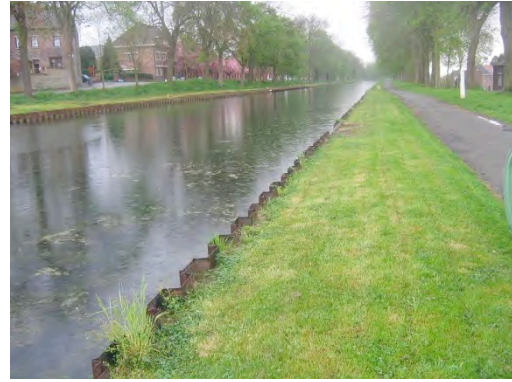
Figure 71 : berge praticable au niveau de la passerelle piétonne
