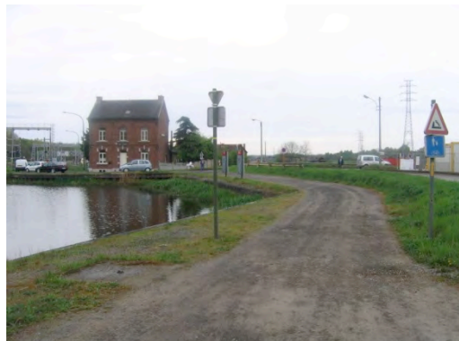
Figure 62 : zone inaccessible en amont de l'Ascenseur n°1
