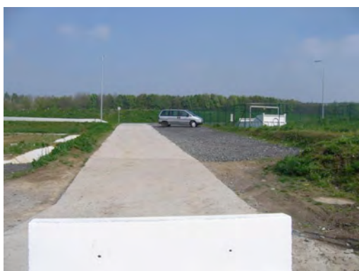
Figure 21 : parking disponible en aval de la porte de garde
