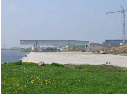
Figure 23 : berge impraticable et inaccessible au quai de Strepy
