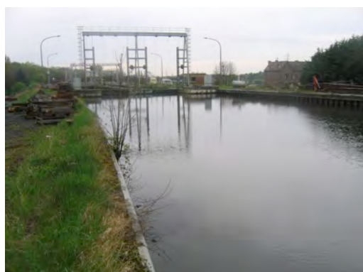
Figure 49 : zone inaccessible en amont de l'Ascenseur 1
