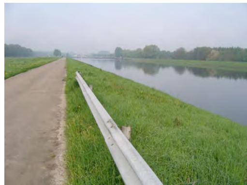
Figure 144 : berge praticable au pont route d'Hensies
