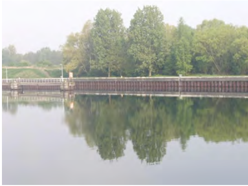
Figure 158 : berge impraticable en amont de l'écluse de Hensies
