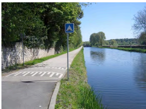
Figure 162 : berge praticable en aval de l'Ecluse n°1
