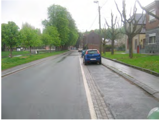
Figure 57 : zone accessible dans la rue de l'Ascenseur
