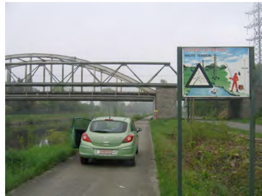
Figure 111 : berge impraticable en amont du pont rue de l'Enfer
