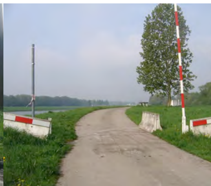
Figure 156 : chemin de halage interdit en aval du pont route d'Hensies
