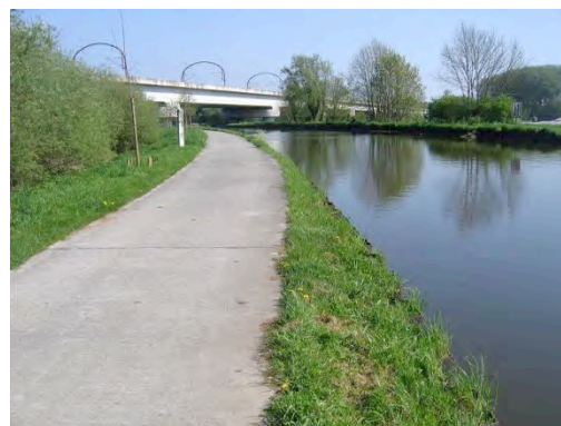
Figure 175 : berge praticable au pont levis des Trois Fontaines
