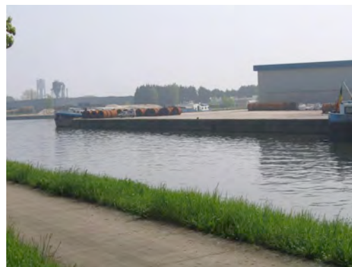
Figure 83 : zone impraticable sur le quai de la Darse Sud
