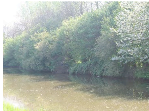
Figure 193 : berge impraticable en aval du pont levis Rosa
