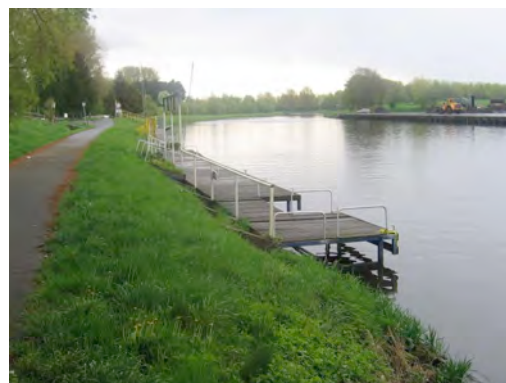
Figure 18 : berge inaccessible au pont Marie Ghislain
