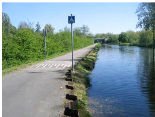
Figure 163 : berge praticable en aval de l'Ecluse n°2
