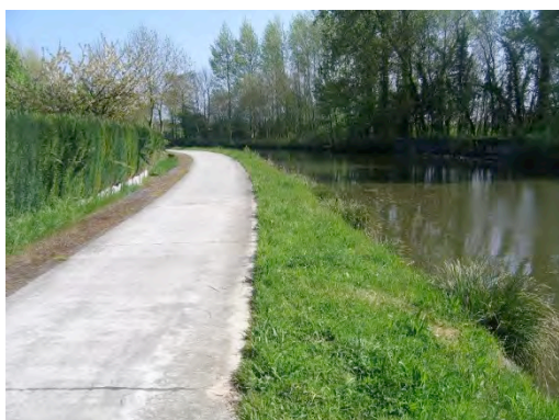
Figure 172 : berge praticable en aval de l'Ecluse n°15
