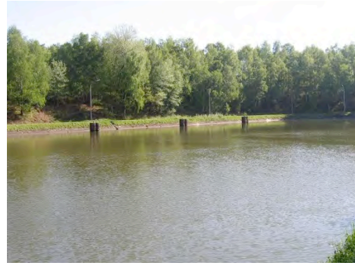
Figure 129 : zone d'embarcadère en aval de l'Ecluse n°1
