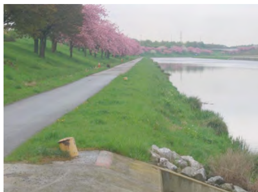
Figure 36 : berge inaccessible et impraticable à la confluence entre l'Embranchement Principal et le Canal du Centre à Grand Gabarit
