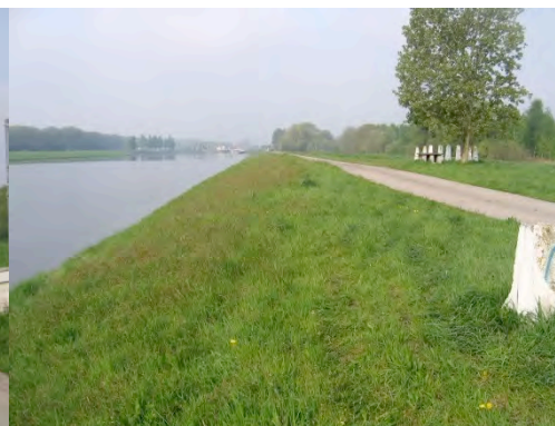
Figure 157 : berge praticable au pont route d'Hensies
