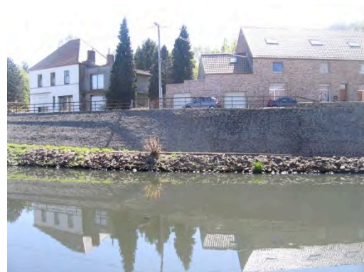
Figure 181 : circulation et stationnement des véhicules sur la rue E. Carlier
