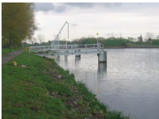
Figure 17 : berge impraticable au niveau des embarcadères à la confluence entre le Canal du Centre et du Canal Charleroi-Bruxelles
