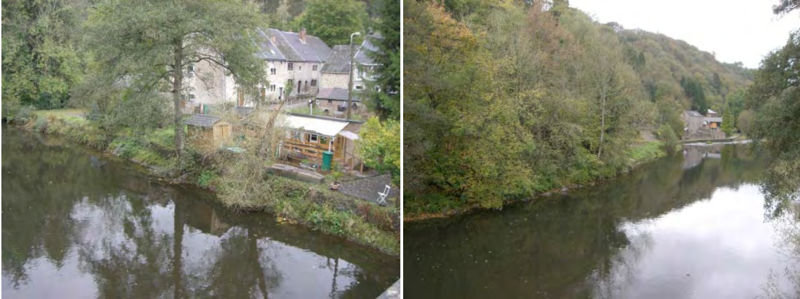
Figure 36 & 37. Aval Pont de Martinrive - Rive droite et gauche
