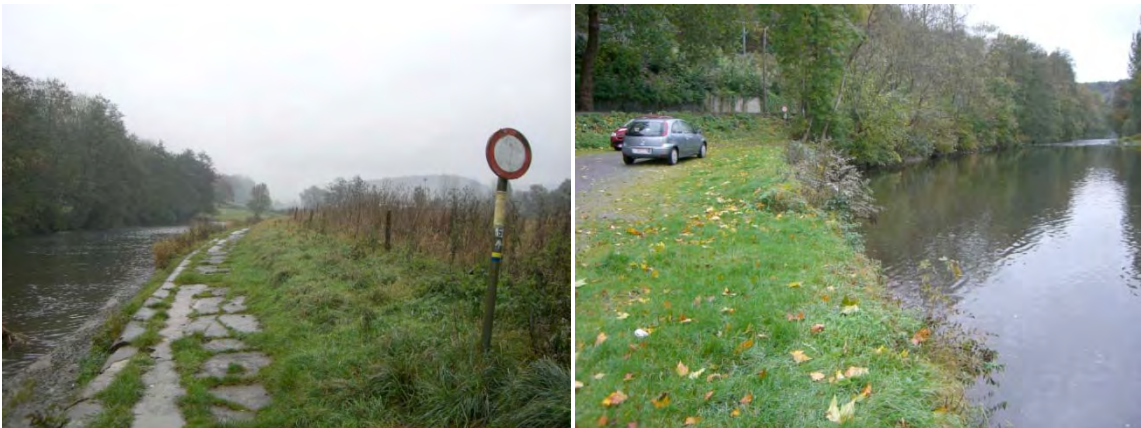
Figure 27 & 28. Vue amont et aval du parking en contrebas de la rue François Cornesse
