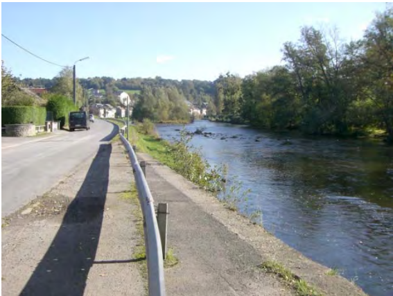
Figure 9. Amont du pont de la N662- Rue du Halage
