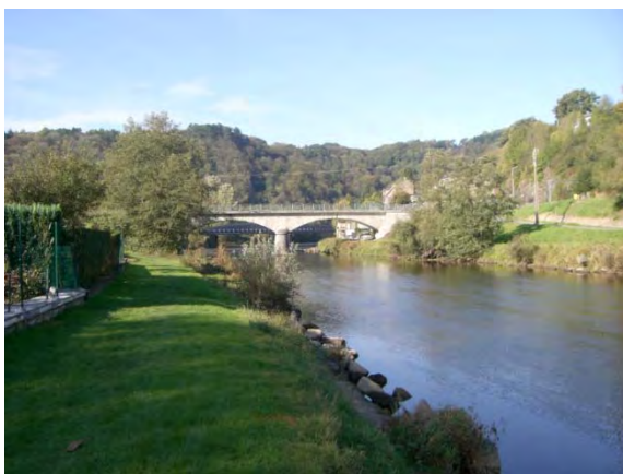
Figure 52. Pont de la rue de Liotte
