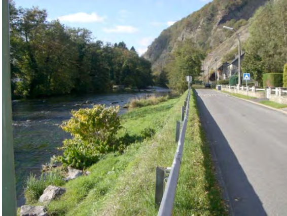
Figure 11. Aval du pont de la N662- Rue du Halage
