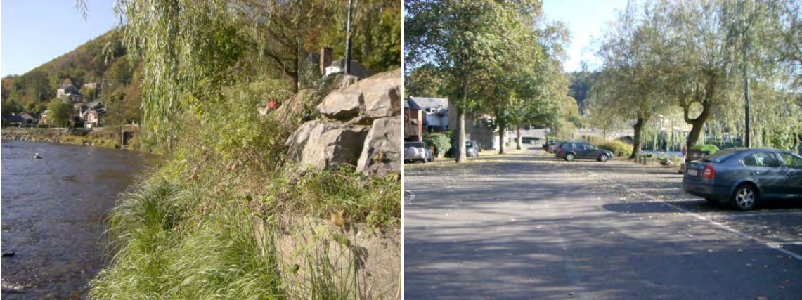
Figure 19 & 20. Aval du Pont d'Aywaille et parking - Rive droite
