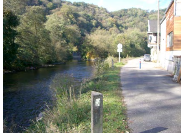
Figure 58. Aval du Pont SNCB de Rivage - Rive droite
