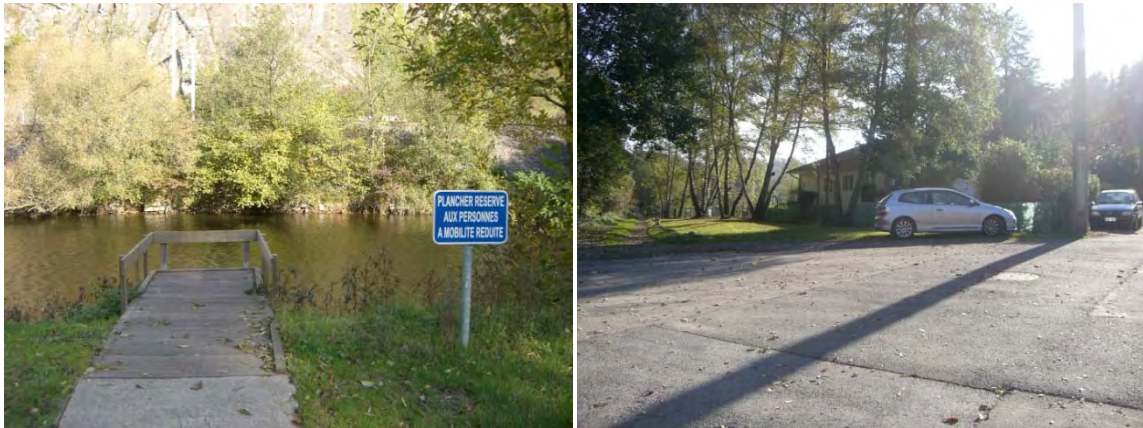
Figure 49 & 50. Pont de Sçay - Plancher PMR et parking - Rive gauche
