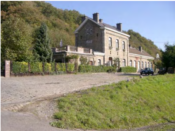
Figure 55. Parking ancienne gare de Liotte
