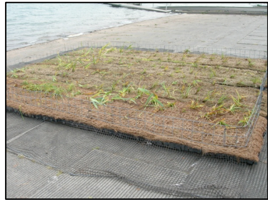
Figure 17 : radeau assemblé avec filet anti-cormoran et grille anti-canard
