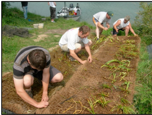
Figure 16 : assemblage d'une île flottante
