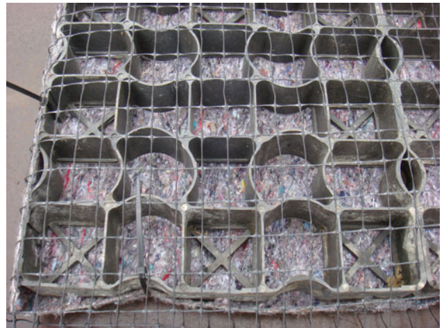
Figure 79 : Dalles de polyéthylène recouvert d'un treillis. Figure 80 : Pose d'un géotextile sous les modules.
