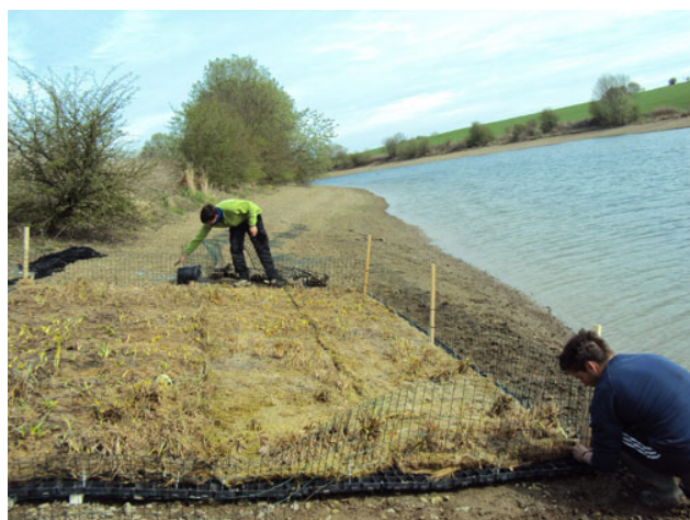
Figure 94 : Fixation de chevron pour fixer un treillis autour du radeau.
