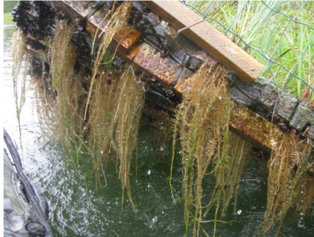
Figure 109 : Racines présentes après seulement deux mois sur les radeaux installés sans bâche.
