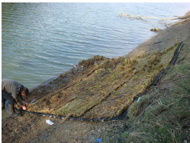
Figure 93 : Quatre géonattes de fibres de coco prévégétalisées sont déroulées sur les modules.
