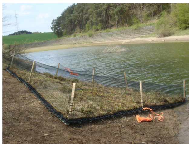
Figure 95 : Mise en place du filet et des cordes pour le lestage du dispositif.
