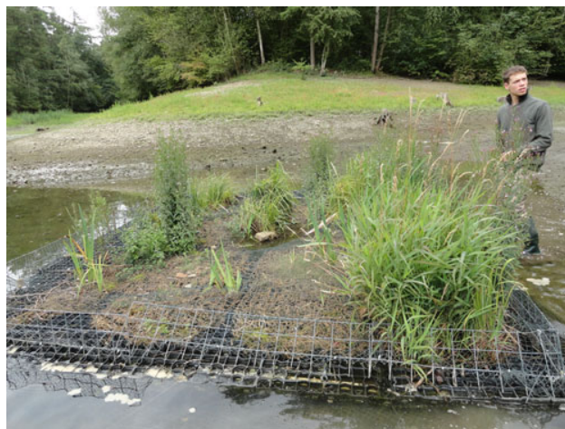
Figure 106 : Reprise variable des géonattes de fibres de coco prévégétalisées.
