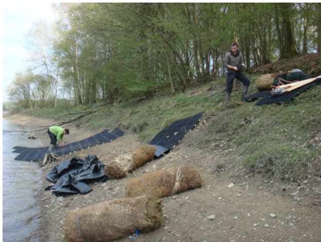
Figure 91 : Assemblage des modules pour constituer un radeau d'environ 20 m 2 .
