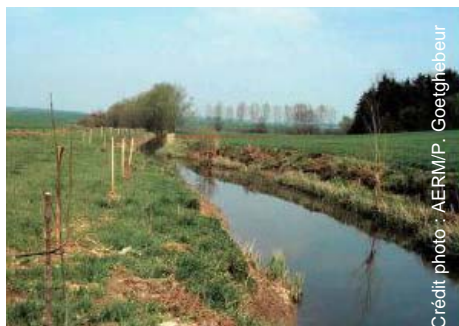
Renaturation d'un cours d'eau en zone agricole : plantations sur les berges de l'Esch à Minorville
