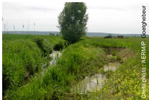
Renaturation d'un cours d'eau en zone agricole : diversification du lit mineur du Moutru à Saint-Hilaire en Woèvre
