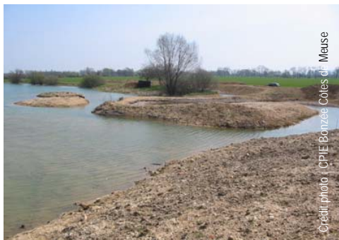
Exemple d'une ballastière restaurée par création de hauts-fonds et d'îlots et retalutage des berges en pente douce
