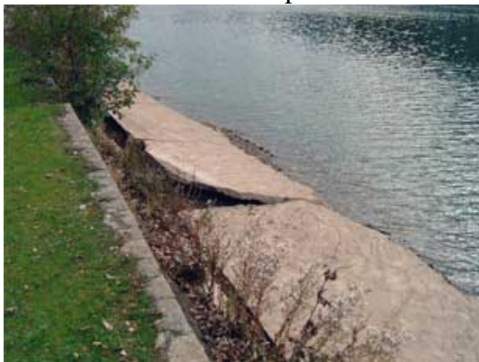
Figure 18 & 19 : Banquette en béton désolidarisée du lit de la Meuse
